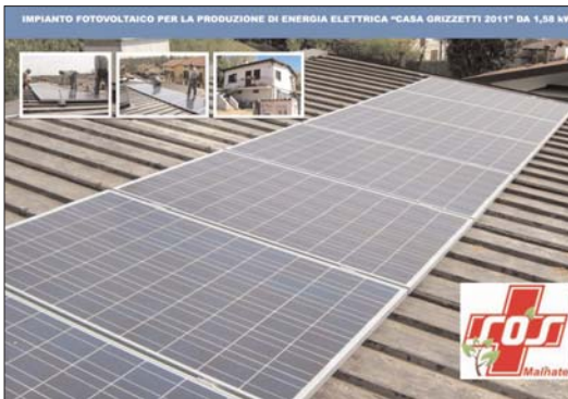
Sistemazione del tetto della sede di via Settembrini (Casa Grizzetti) con l'installazione di un impianto di pannelli fotovoltaici.
